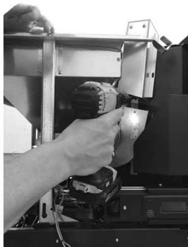
Fig. 44 - Secure the fan
